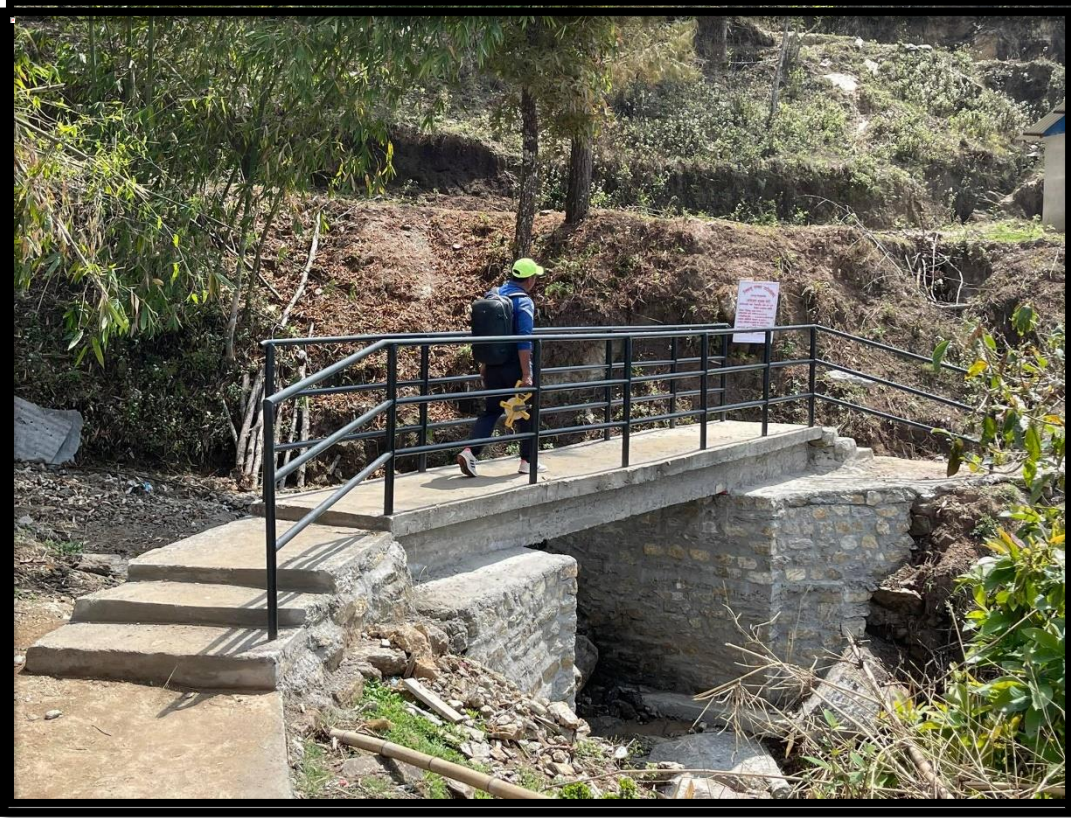
चिवास्योड खोला ट्रस पुल निर्माण (वडा नं.१), बजेट रु. ५ लाख
